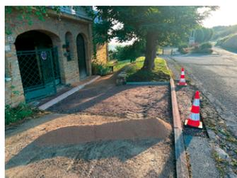
Reprise des bordures déformées par les racines d'arbres et amélioration de l'écoulement des eaux de pluie
